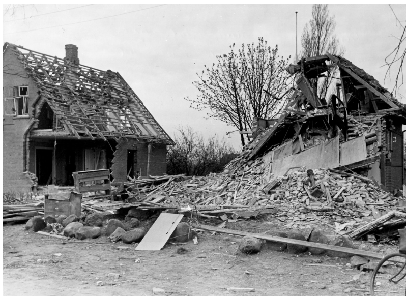
Skader på huse på Husmandsskolens Allé. (PLA).
