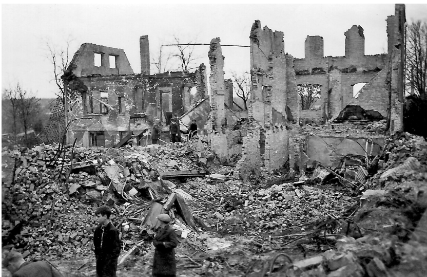
Et par nysgerrige drenge er ude at se på ruinerne af Husmandsskolen.
