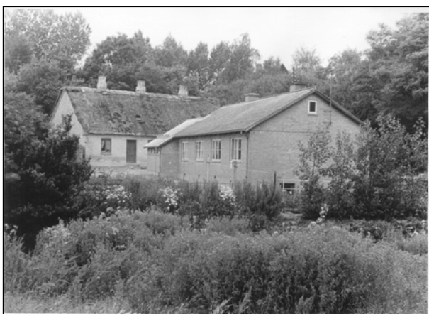
Der er bygget en toiletbygning på huset til højre.
