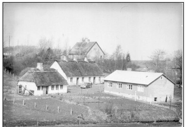
Dette billede er – vistnok – det eneste med alle tre brohuse. Huset længst til højre blev bygget i 1957, og kort efter blev det ældste revet ned.
