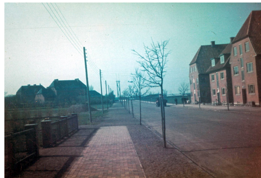
Et af de angribende Mosquitofly anes midt i billedet lige over stadion. Det er på vej til Husmandsskolen. Bolbro Skole til venstre (SO)
