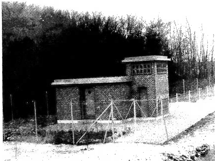
Tarup gamle Vandværk på Jernbanevej 1933
